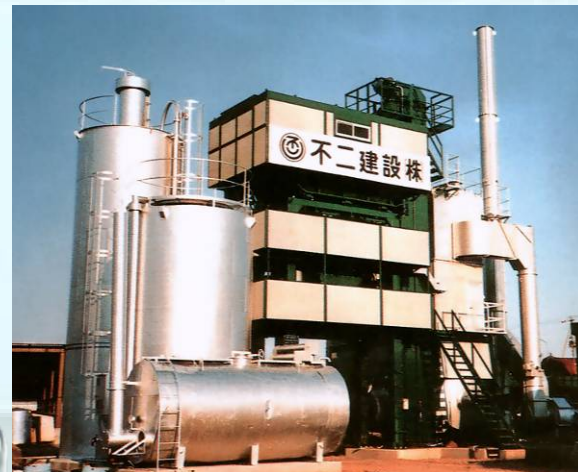
アスファルトプラント
